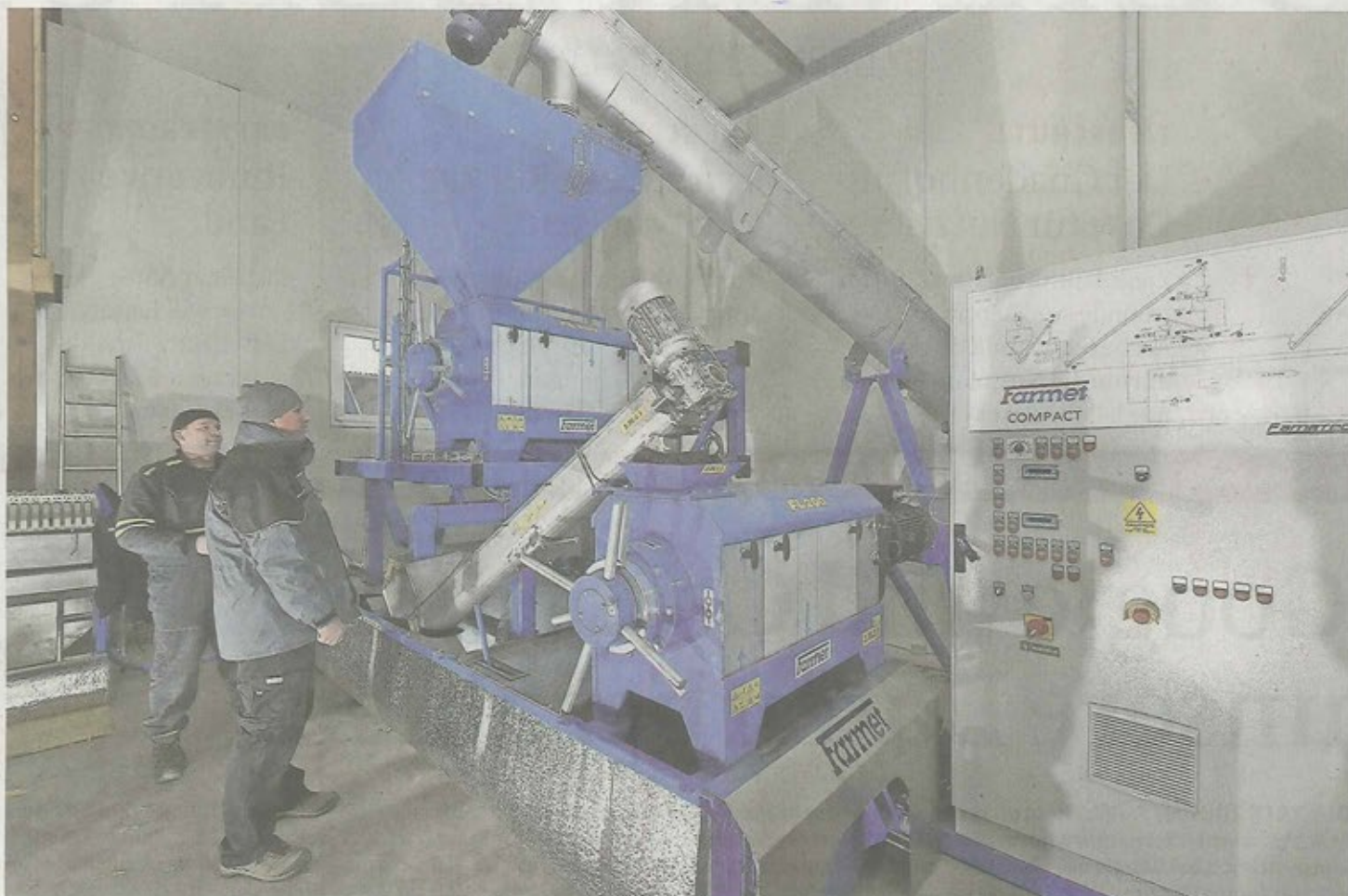
Die neueste Anschaffung der Landi Landshut: Die letzten Installationsarbeiten werden erledigt, bevor die Rapsöl- presse in Betrieb geht. Bilder Thomas Peter
